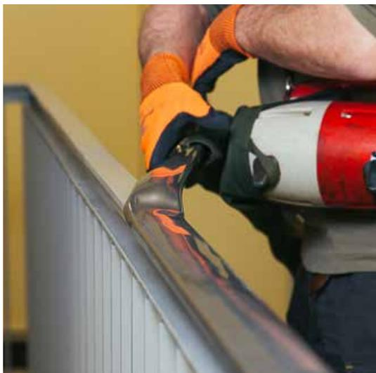
HL gleichmässig Erwärmen mit Durchlauferhitzer mit Luftschlauch.
