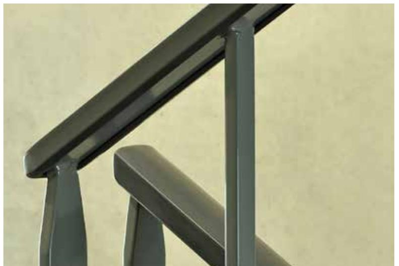
Die Staketen und Konsolen sind innerhalb der Profilloffnung zu platzieren.
